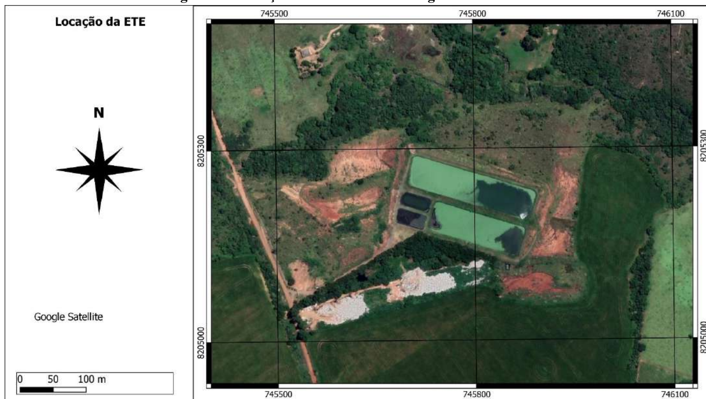
Figura 49 - Estação de Tratamento de Esgotos Abadiânia.
