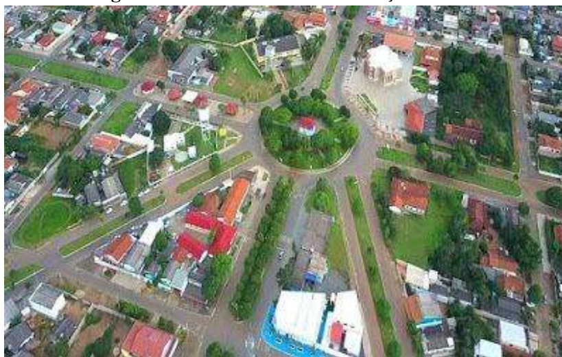
Figura 19 - Vias Urbanas e edificações locais.
